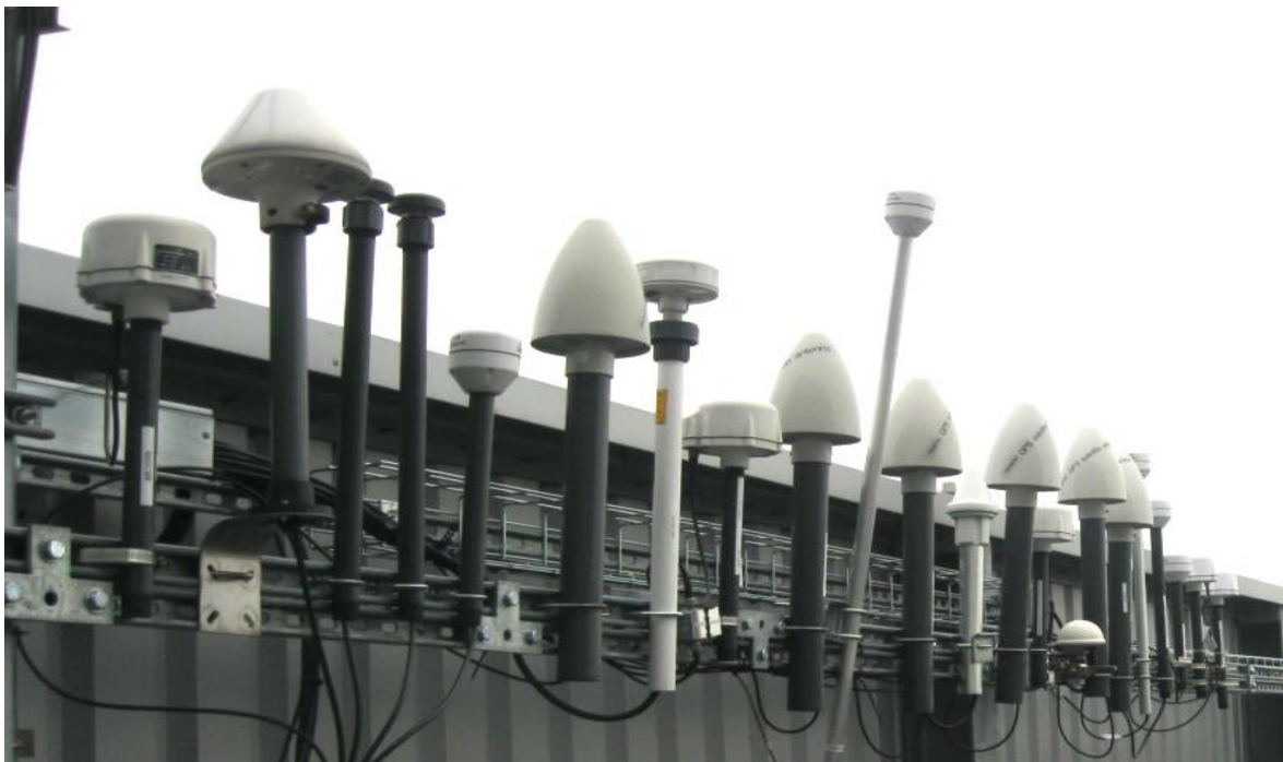
Rys. 16. Widok dachu zakładu przemysłowego na przełomie drugiej i trzeciej dekady XXI wieku. Ilość anten odzwierciedla charakterystyczny dla Przemysłu 3.0 proces relacji jeden PC steruje jedną linią produkcyjną (lata 1980-2020). Zbyt blisko położone anteny GNSS interferują i są łatwym celem ataku TAS. Duża liczba zróżnicowanych odbiorników zwiększa ryzyko przepełnień
